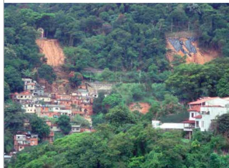
Deslizamentos de terra em 2010, ao longo da via do trem do Corcovado, por desvio de águas pluviais
